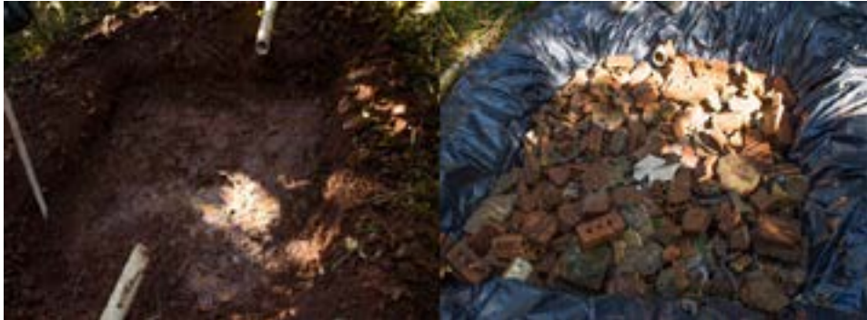
Figura 2 – Escavações do sistema wetland realizadas.
